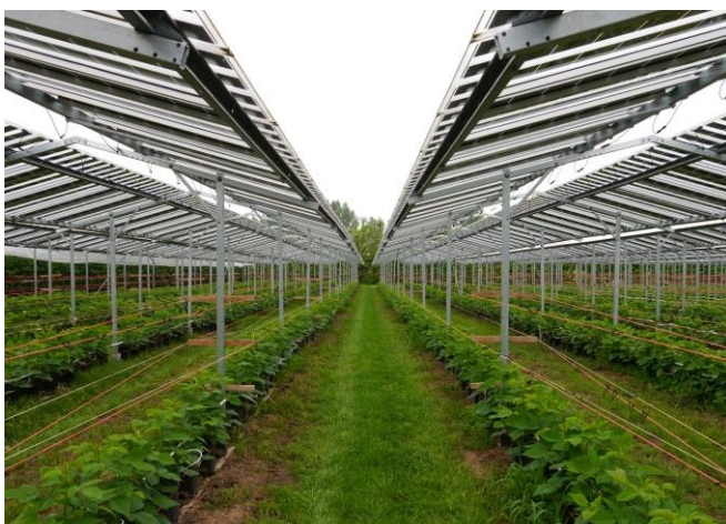
Afbeelding 6 - Agri-PV Babberich: hier worden frambozen geteeld onder semi-transparante zonnepanelen, die voldoende licht doorlaten en het fruit beschermen bij slecht weer. (Foto: Dirk Oudes)
